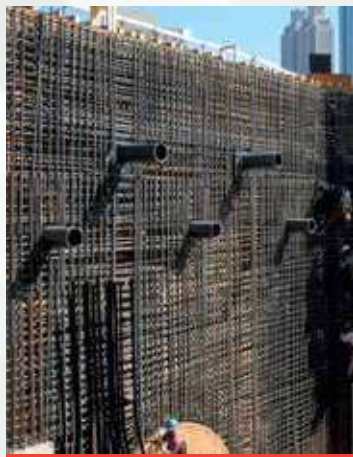
Elementos densamente armados
